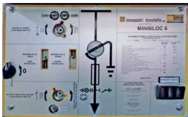
Comando tipo RI6Q-SV ad accumulo di energia Power stored RI6Q-SV type operating mechanism
