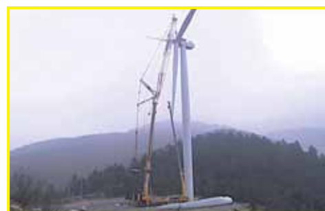
Assistenza ai montaggi delle torri eoliche
